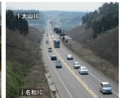
【写真④】名和・淀江道路 (供用済み区間) (名和IC付近から大山IC方面を望む)
