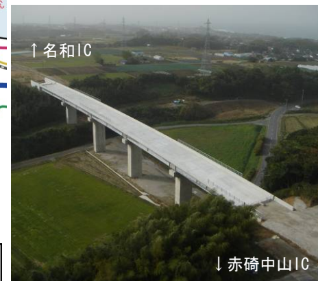
【写真③】名和・淀江道路 (寺谷川橋の施工状況)
