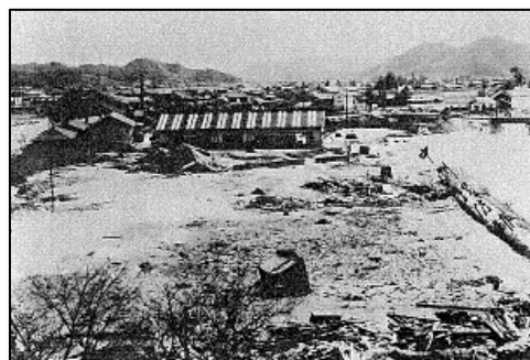
昭和20年9月洪水(府中市土生町)
