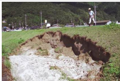
洪水による堤防の損傷事例（福山市新市町）
