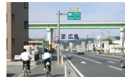
整備後の歩行者・自転車空間
