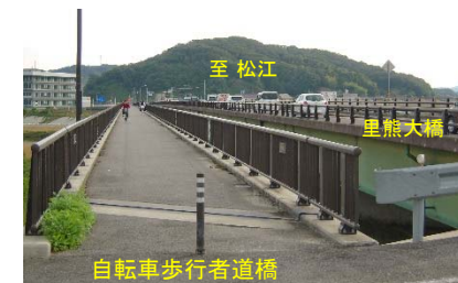
整備後の里熊大橋側道橋
