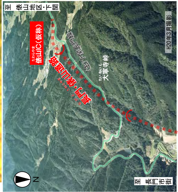
下関長門線 大寧寺峠周辺の道路状況（写真①）
