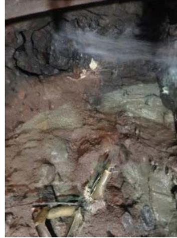
写真2 湧水発生状況(1時間あたり約130トンの出水)
