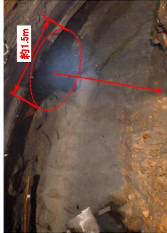
写真1 掘削先端部の天井部分からの崩落
