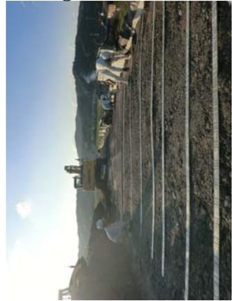
③粒度調整した掘削残土を補強土壁の背面盛土材に使用 (左写真は、鋼製補強材の敷設及び背面盛土の施工状況)。
