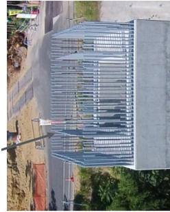
より大きい構造物ほど、高強度鉄筋の採用により断面の縮小が図られ、コスト縮減の効果が大きい。
