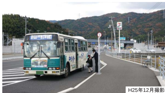
国道2号戸田拡幅区間 湯野温泉口停留所の状況
