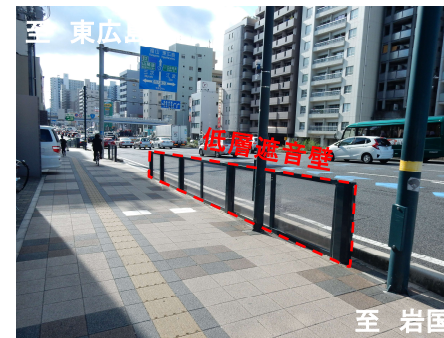
【写真③】低層遮音壁設置状況 (R元年9月)
