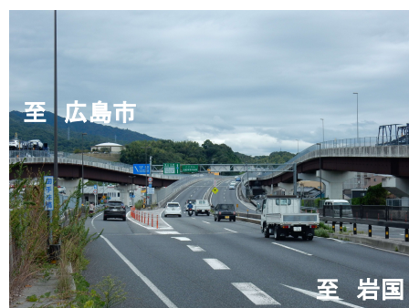
【写真①】廿日市高架部の状況 (R元年9月)
