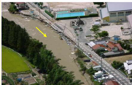
支川玖島川友和地区の河岸洗掘
