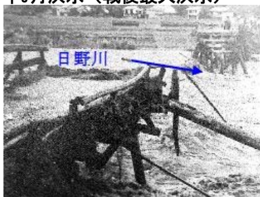
洲河崎橋梁の落橋（江府町洲河崎）
