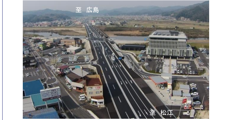
【写真②】 里熊大橋～里方交差点 延長0.5km 平成28年3月開通(4車線)
