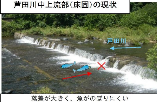
芦田川中上流部(床固)の現状
