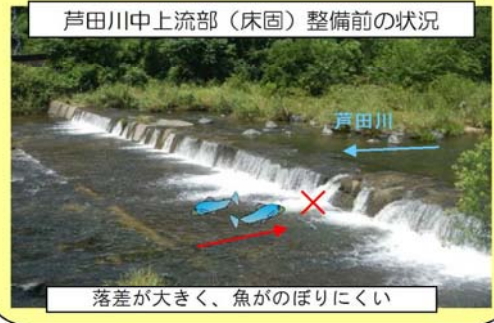
芦田川中上流部（床固）整備前の状況
