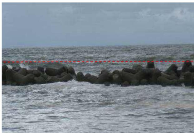
▲ 離岸堤ブロックの沈下（皆生工区1基）
