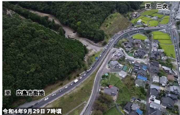
写真②: 暫定2車線開通状況
