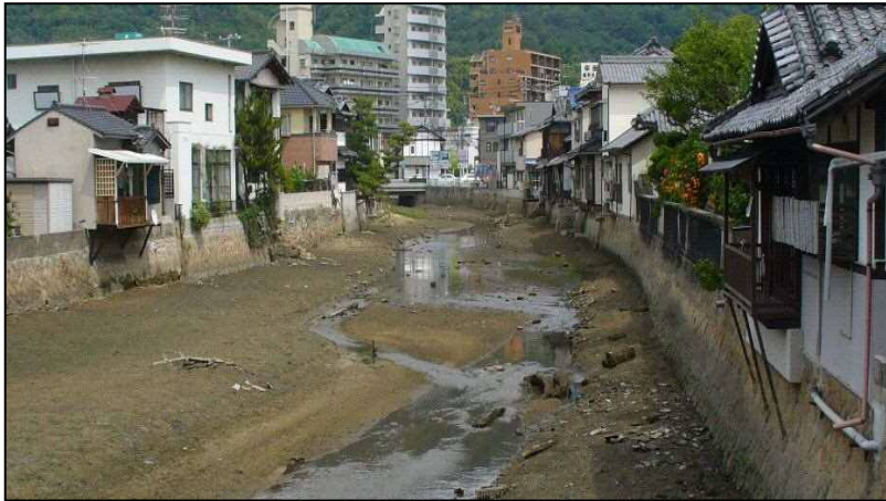
整備前の状況（宮下川）
