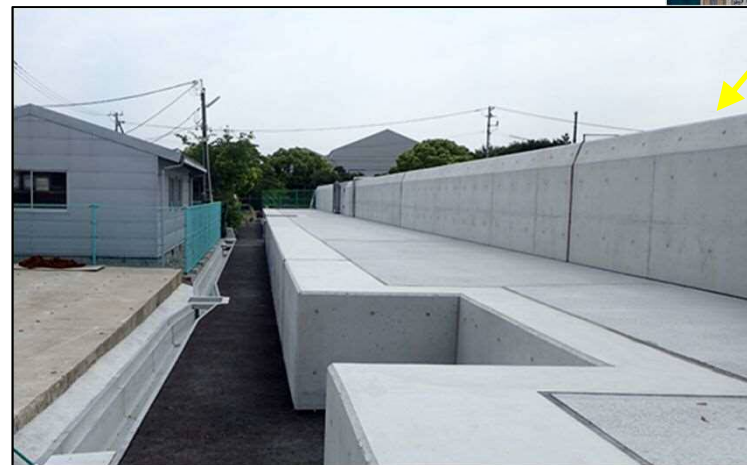
整備後の状況（江波西部）
