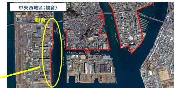
平成16年台風18号による浸水状況
