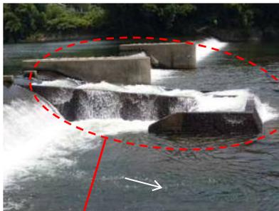
水の流が集中し魚道内の流速が速い。また、流量が増えると魚道の横から水が溢れ落ちる。
