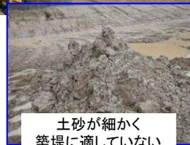
土砂が細かく築堤に適していない
