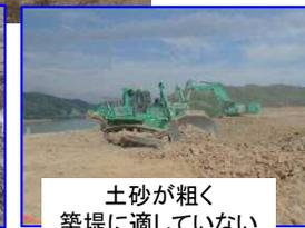
土砂が粗く築堤に適していない
