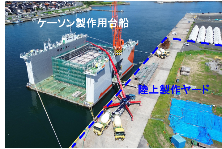
【ケーソン製作用台船による施工イメージ】
