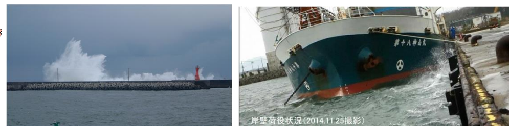
※荒天時防波堤越波状況、係留貨物船動揺状況 鳥取港にて撮影
