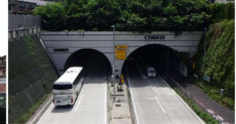
整備後：渋滞が解消され、バスが走行している状況 (長迫側(西側)坑口付近) R5.7撮影
