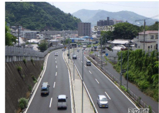
写真②終点側坑口付近
