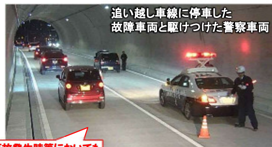
事故発生時等においても通行が可能に
