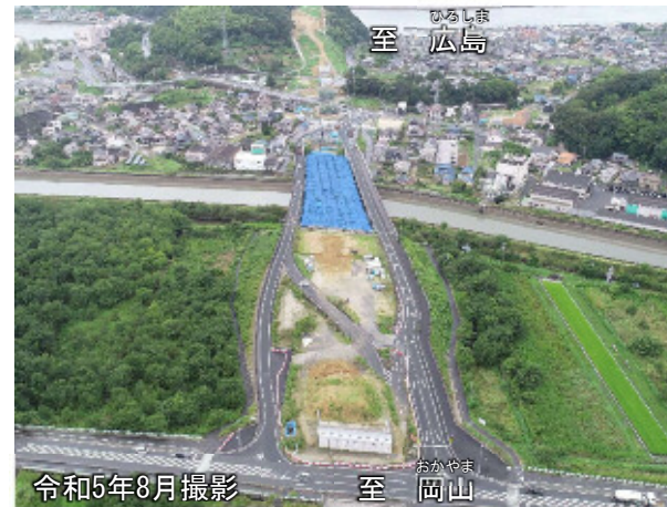
【写真②】笠岡東IC(仮称)付近の進捗状況
