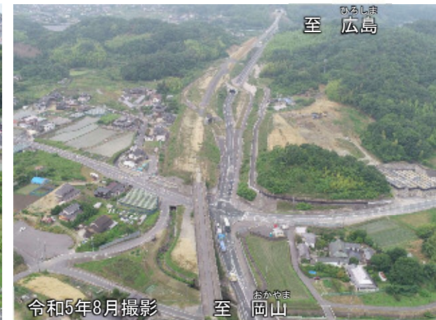
【写真③】浅口金光IC付近の進捗状況
