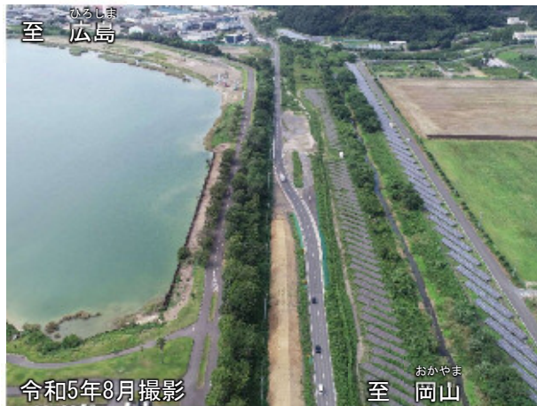
【写真①】笠岡西IC(仮称)付近の進捗状況
