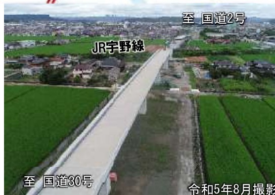
【写真②】本線JR部高架橋付近の進捗状況
