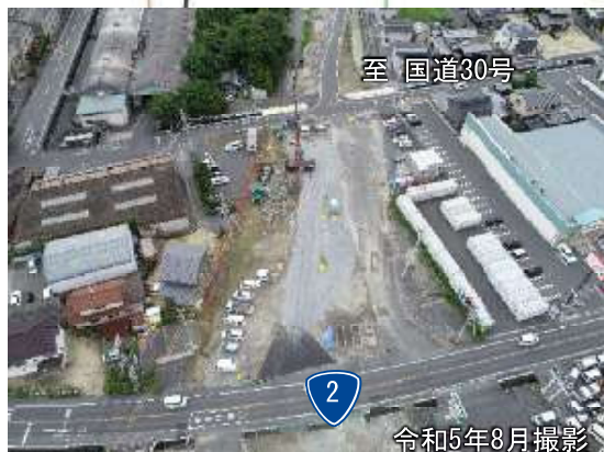
【写真①】古新田地区の進捗状況
