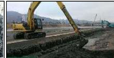
他事業の現場作業状況
