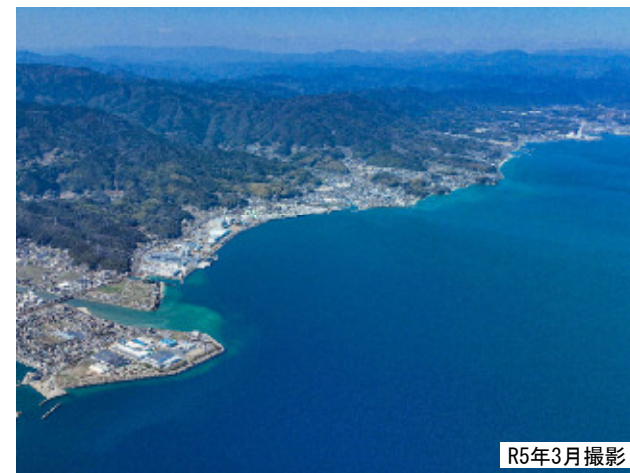
終点部付近から大竹方面を望む(写真)
