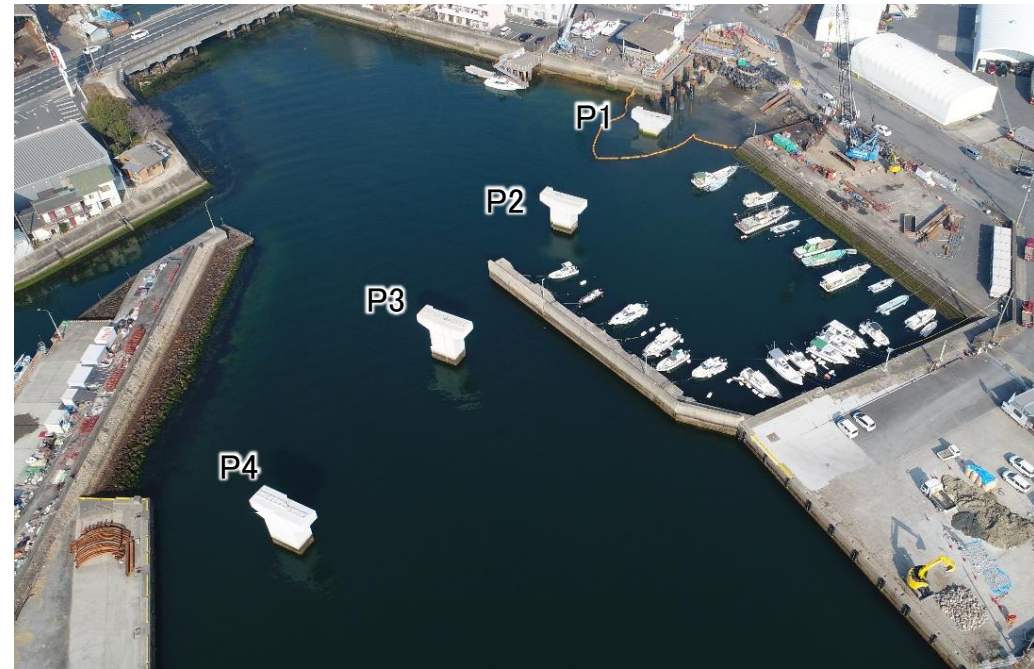
Ⅱ期区間 3号橋(仮称)の橋脚整備状況
