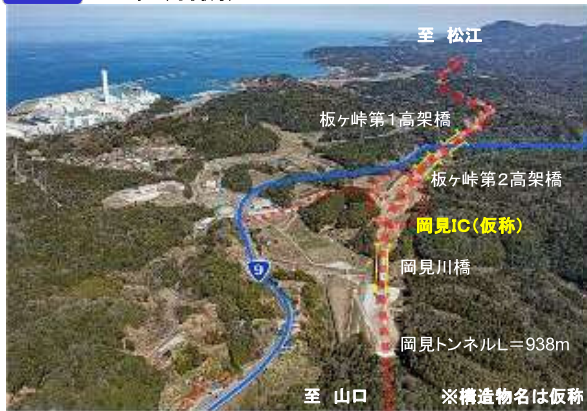
①山口市方面より岡見IC(仮称)を望む
