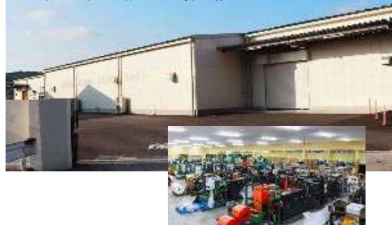
2020年益田市に建設された新工場
