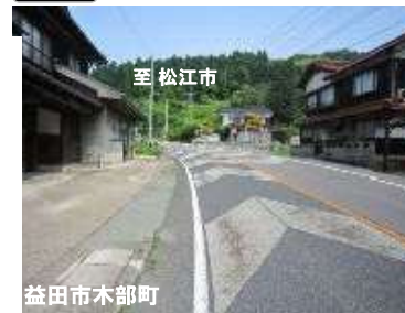
線形不良箇所(R=100)
