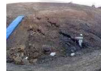
【写真①】切土のり面 崩落状況
