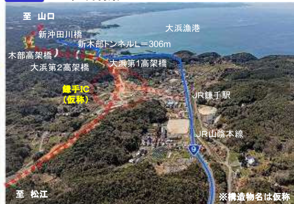
②松江市方面より鎌手IC(仮称)を望む
