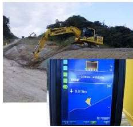
【法面整形状況(盛土部)】
