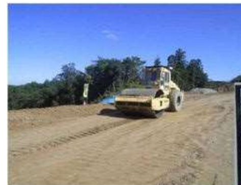
【盛土の転圧状況】
