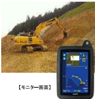
【法面整形状況(切土部)】
