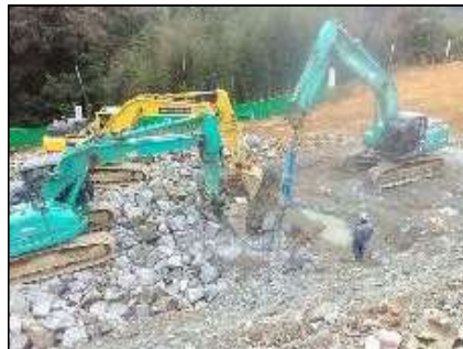
割岩工法による施工状況写真
