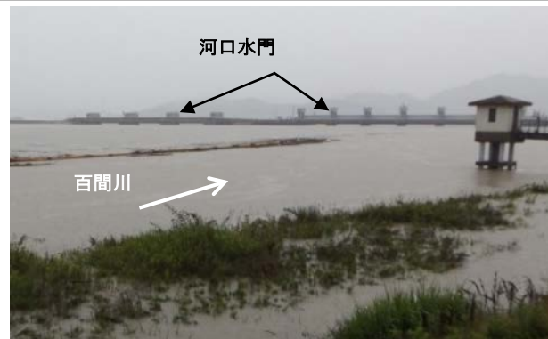
平成30年7月豪雨の状況(右岸上流より)
