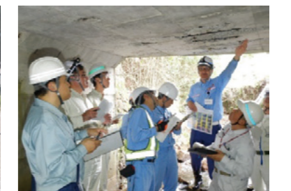
自治体への技術的支援 (道路構造物の点検実習)
