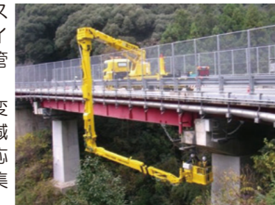
橋梁の長寿命化対策 (橋梁点検車による点検)
