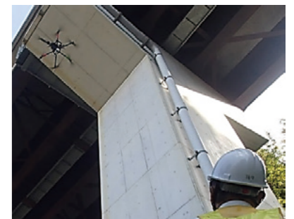
ドローンを活用した橋梁点検の効率化
