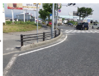
安全防護柵の設置（鳥取県）
