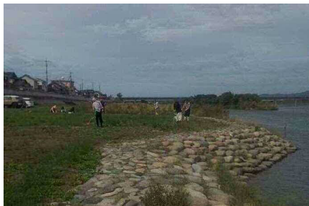
親水護岸付近の除草・清掃
