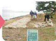
土のうを敷く作業
