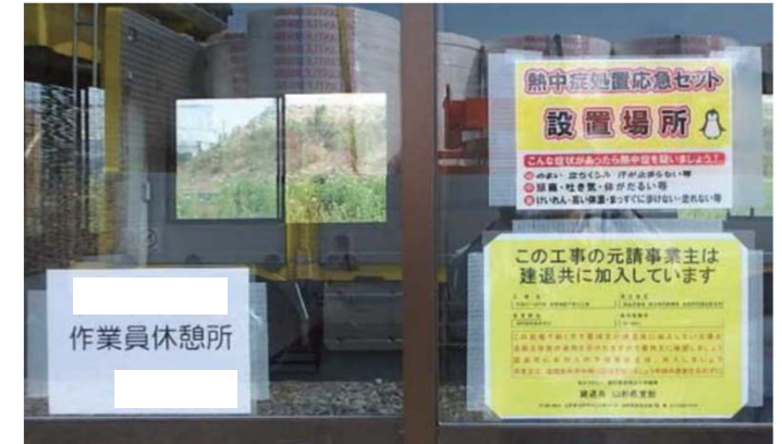
熱中症対策キットの設置場所の明示
