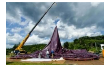
設置中の様子
