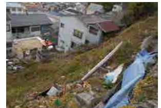
高台から瓦礫や岩石、柵等が落下するおそれ
