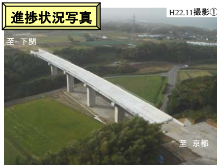
大山町小竹地区 工事状況(寺谷川橋)
