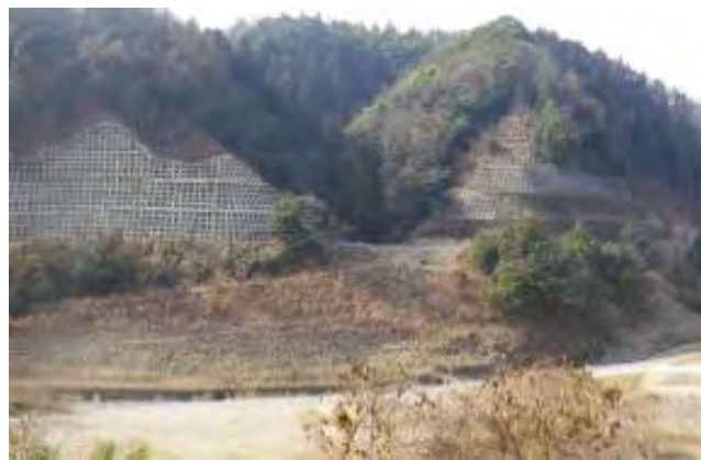
付替市道中仁賀線(H23年3月撮影)
