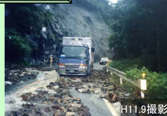
写真③現道(国道191号鎖峰)の災害状況
