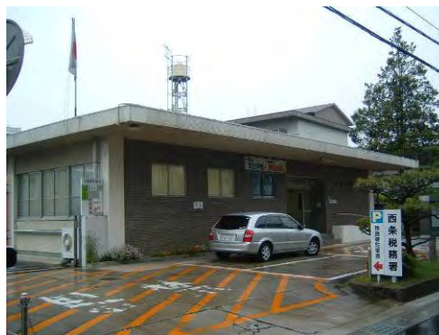
西条税務署 現庁舎の状況
