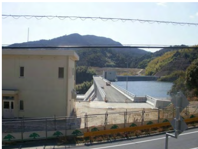
試験湛水状況(左岸より堤体を望む) (H23.3)
