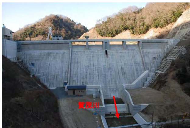
ダム本体下流側(H23年3月撮影)
