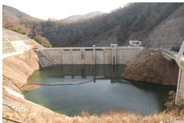
試験湛水状況(H23年3月撮影)
