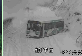
写真④現道(国道191号鎖峰)の冬期の状況
