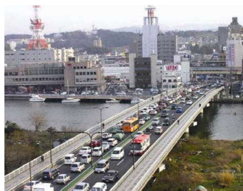
国道485号の渋滞状況(くにびき大橋)
