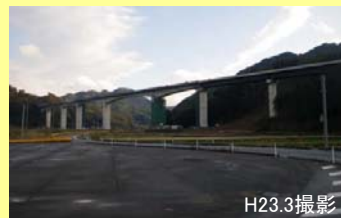
写真① 吉広高架橋
