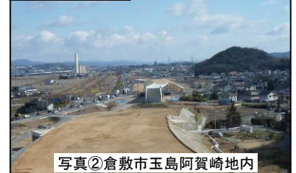
進捗状況写真
