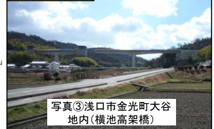
進捗状況写真
