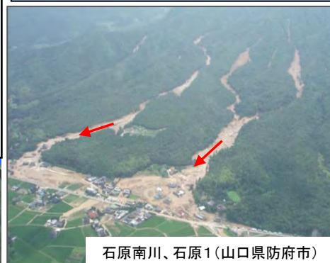
平成21年7月豪雨災害による被災状況
