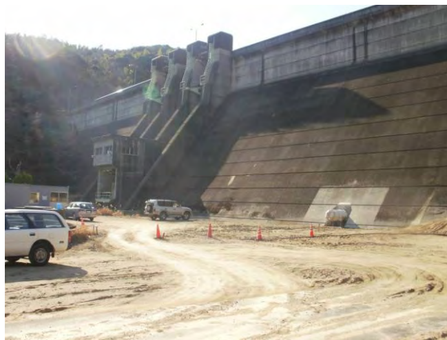
既設黒杭川ダム放流設備工事状況 (H23.3)
