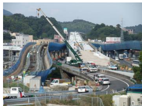
【写真①】廿日市IC付近から東方向を望む（H22.11撮影）
