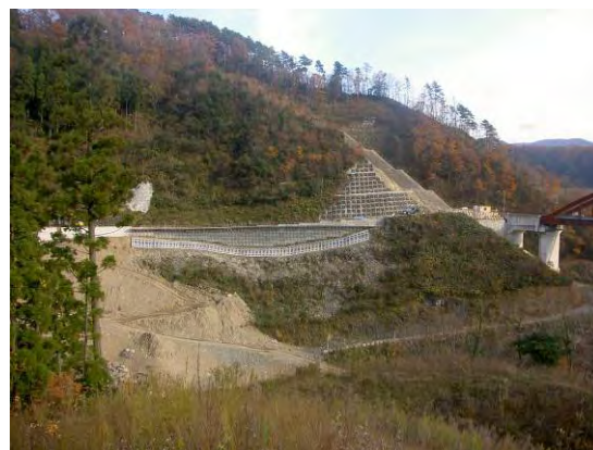
市道付替道路工事(かんごとのせん 神護殿線) (H22.12)
