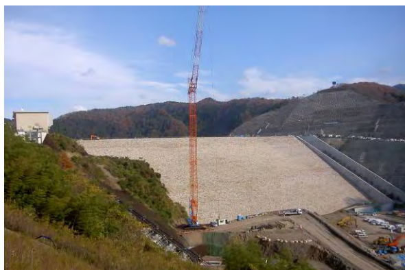
ダム盛立て完了状況 (平成22年12月)
