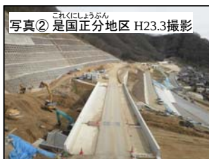
工事進捗状況
