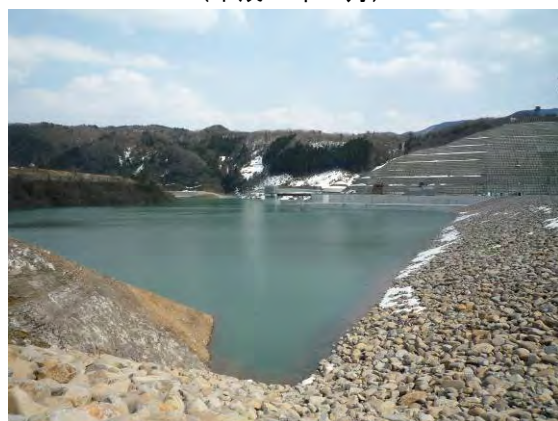
ダムサイト状況(右岸より)(H23.3)
