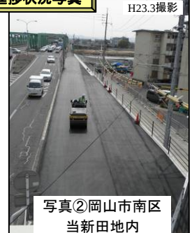
進捗状況写真
