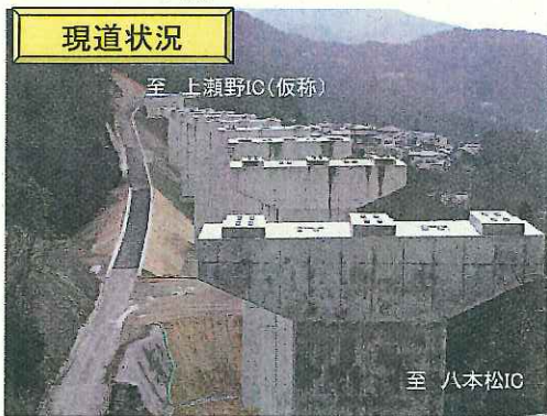
【写真①】大山高架橋付近から西方向を望む(H23.3撮影)
