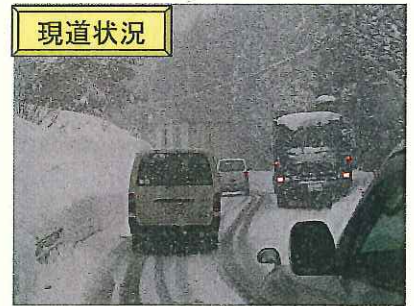
写真② 西城町小鳥原 冬季状況 (積雪時、堆雪幅が確保されておらず 離合が困難)
