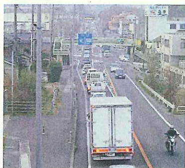
国道2号里庄駅前交差点付近
