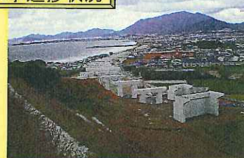
写真③工事施工状況(綾羅木地区)H23.3
