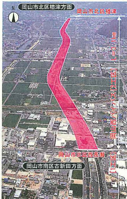
起点部（岡山市南区古新田）から北方面を望む 渋滞発生状況
