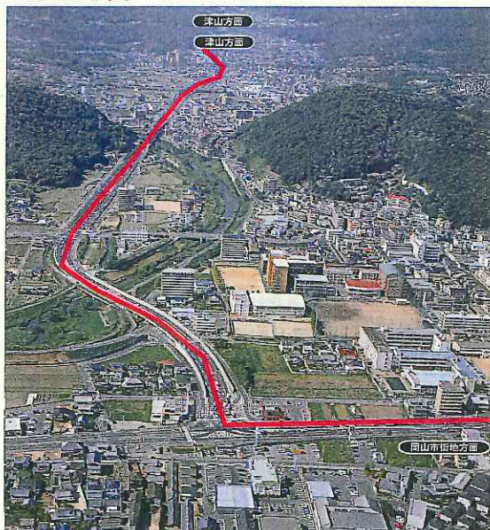
津島京町交差点より北部方面（津山方面）を望む
