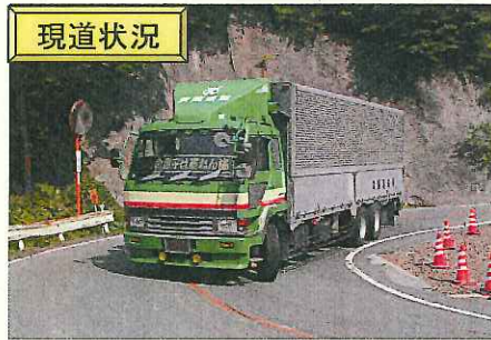
写真① 西城町小鳥原 曲線半径R=11.5m (対向車線にはみ出して走行する大型車)
