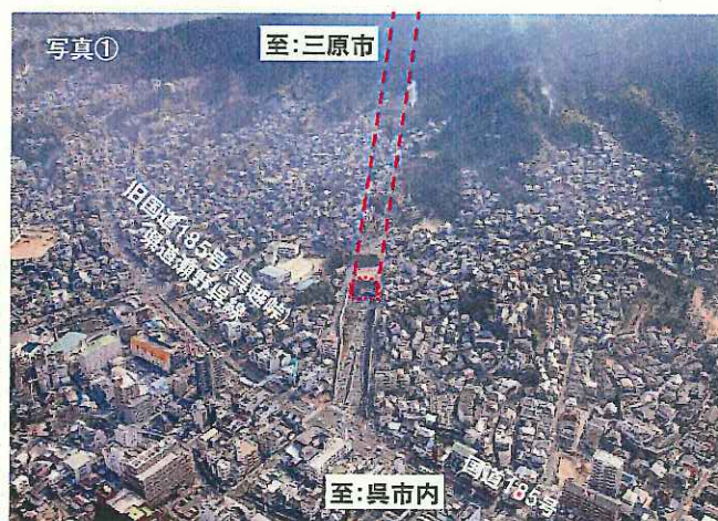
呉市街上空から休山トンネル西側坑口を望む(H21年1月撮影)
