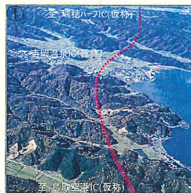
吉岡温泉IC(仮称)付近
