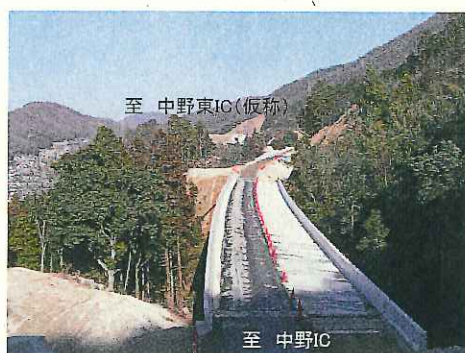
【写真②】清光寺川橋付近から東方向を望む (H23.2撮影)
