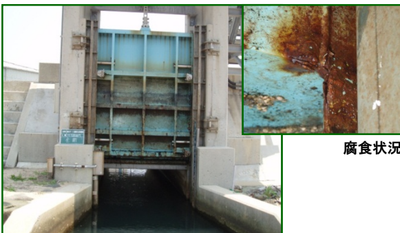
劣化により腐食の進行したゲート
