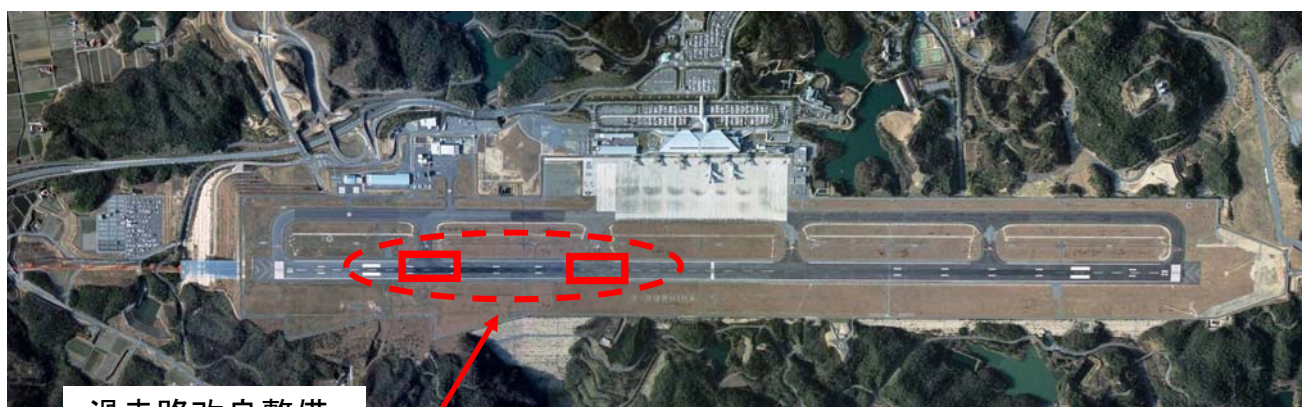
滑走路改良整備
