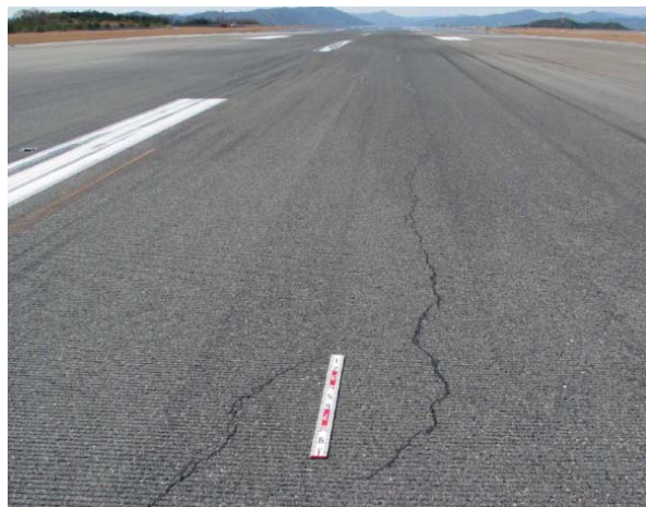
舗装表面の経年劣化によるひび割れの発生
