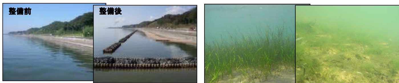
宍道湖や中海の殆どが人工湖岸です。 (事例: 宍道湖のコンクリート護岸)
