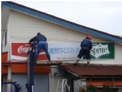
①看板の撤去
