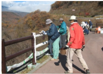
防護柵塗り替え中
