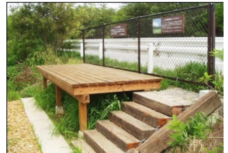
展望デッキ完成
