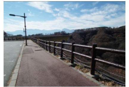
防護柵塗り替え後
