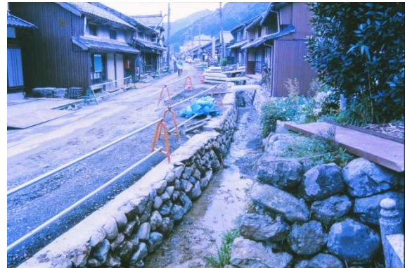
石積護岸の復元
