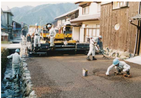
地道風舗装工事の様子
