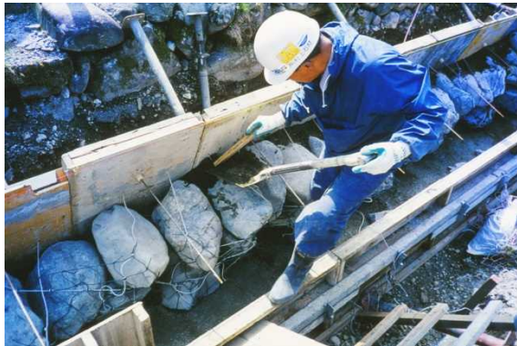
石積護岸工事の様子
