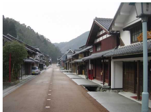
整備後の様子(平成20年)
