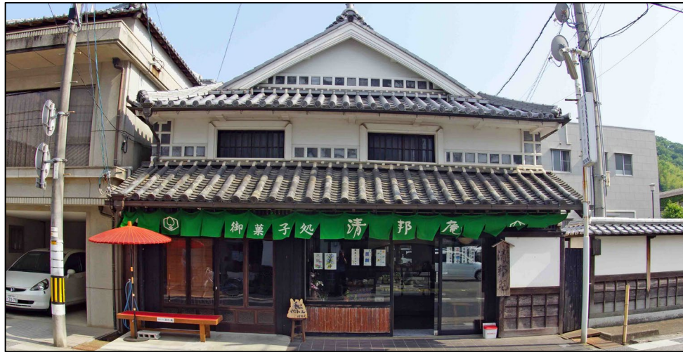
↑地割側溝 妻入↑ 地割側溝↑
