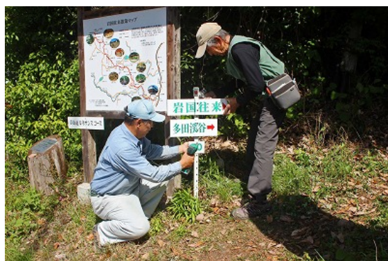
標識の木製杭をスチール製杭に交換
