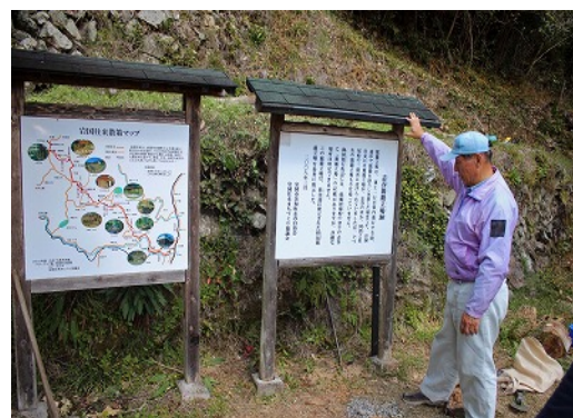
地図・案内板の杭の補強
