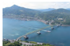
大島瀬戸にかかる大島大橋
