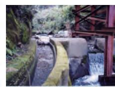
新庄へ農業用水を導いたため取水口、黒杭川ダム建設に伴い、460m上流の現在地に移動。黒杭川上流で古い井戸水没。
