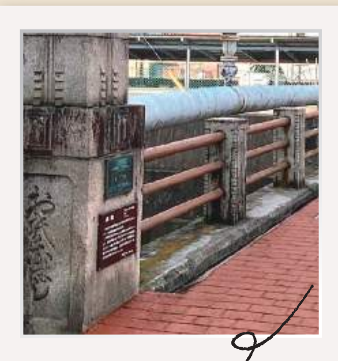
翁橋[国登録有形文化財]「土木遺産」 アールデコ調の欄干とレンガ舗装が特徴的な大正時代の橋
