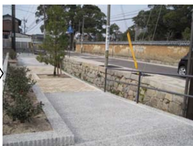
石組道台を保存展示した水路改修（整備中）
