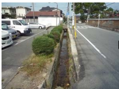
道台を兼用した用水路（整備前）
