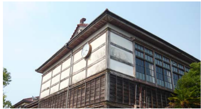
写真 萩藩校明倫館整備事業 (明倫小学校の改修・補修)
