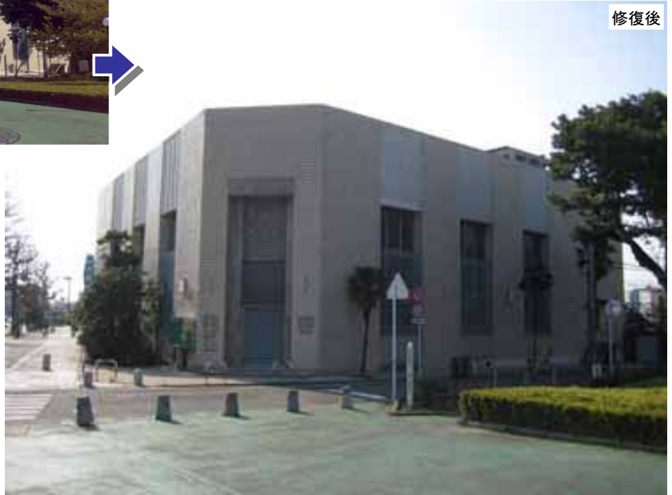
写真 村野藤吾設計の旧宇部銀行の修復状況
