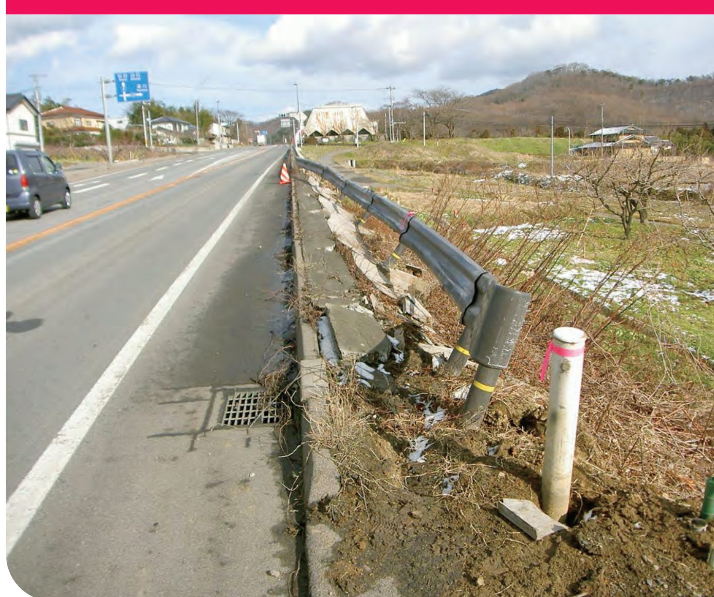
ガードレール・標識等の損傷
