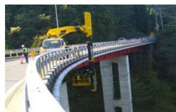
▲橋梁定期点検
