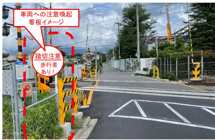
写真 2-7-26 車両への注意喚起看板等の設置イメージ
