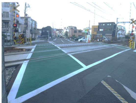
写真 2-7-24 カラー舗装を導入した事例
