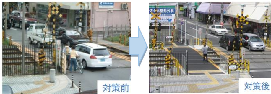
写真 2-7-23 踏切拡幅（歩道新設）の事例
