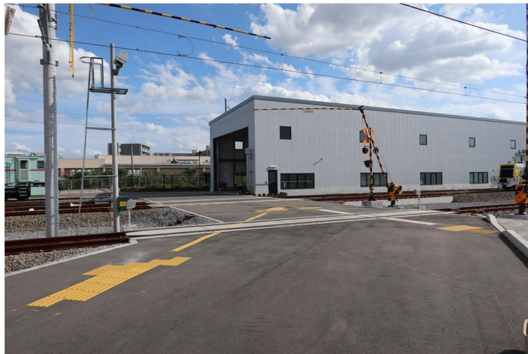
写真 2-7-20 最終確認実験の誘導表示等の敷
