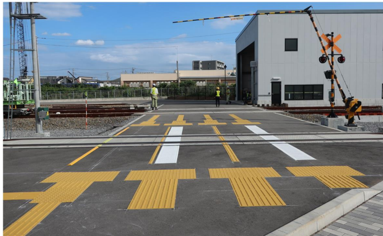
写真 2-7-19 本実験の誘導表示等の敷設状況
