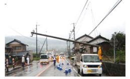
沿道の電柱の倒壊による道路閉塞
