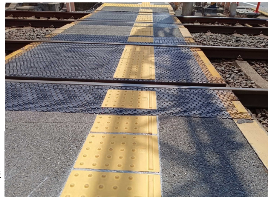
「プラットフォーム縁端警告用内方表示ブロック」と同様の構造を使用
