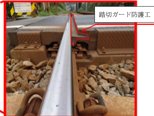
写真 2-7-34 踏切ガード防護工の設置事例
